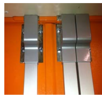
Barra TOP Pestillo superior simple (Hoja Activa) Pestillo superior doble (Hoja Pasiva)
